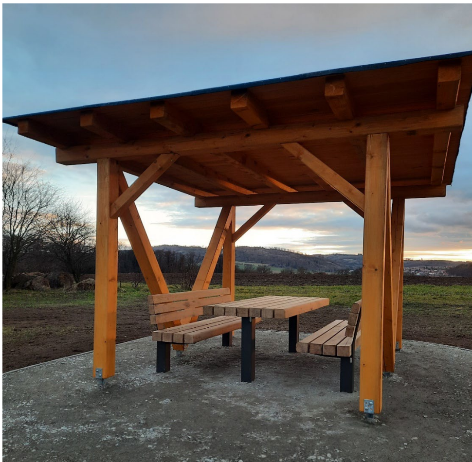
Nově zbudovaný altán v lokalitě Zlámanina u asfaltové polní cesty.
