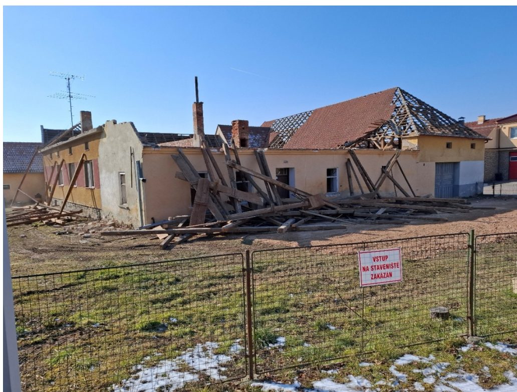
Demolice nemovitosti č.p. 36 na ulici Chlumská
