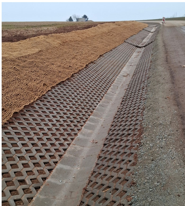
Sanace příkopu polní cesty C24 k vodojemu
