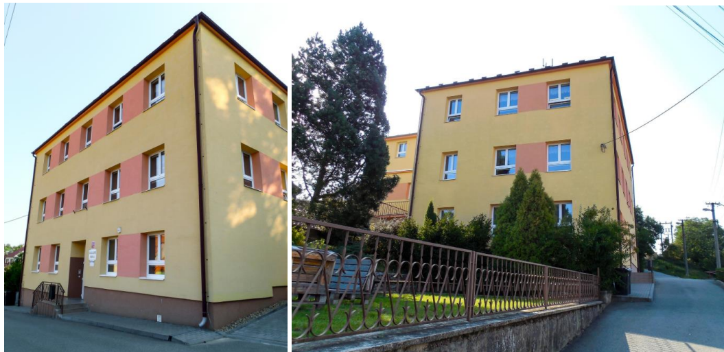
Obr. 15: Základní škola Bořitov 17
